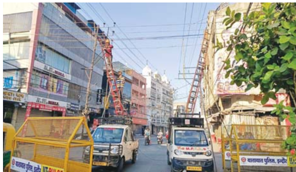
विद्युत मंडल ने कल रंग पंचमी पर निकलने वाली गेर मार्ग पर जहां-जहां केबल वायर नीचे थे उन्हें ऊंचा करने का काम अंतिम रूप से किया, जो आज शाम तक जारी रहेगा।
